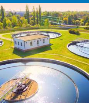
Tratamiento de Agua
